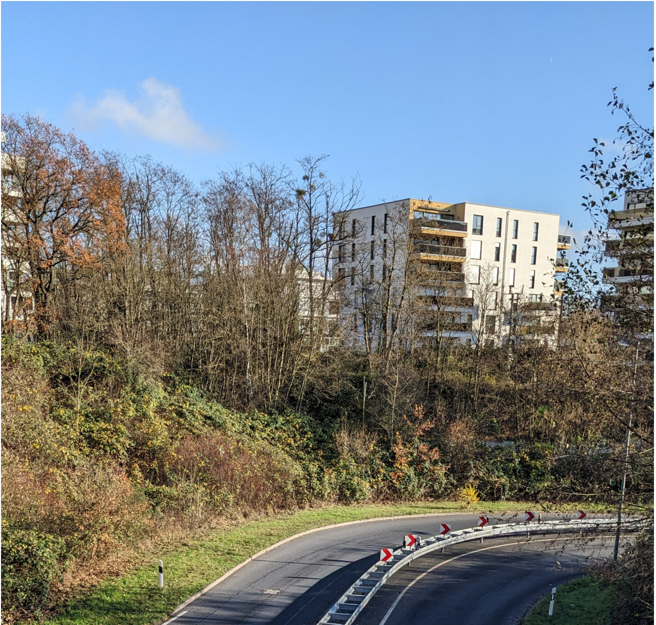
Foto Stadt Oberursel: Fußgängerbrücke Rtg. Südost, November 2024
