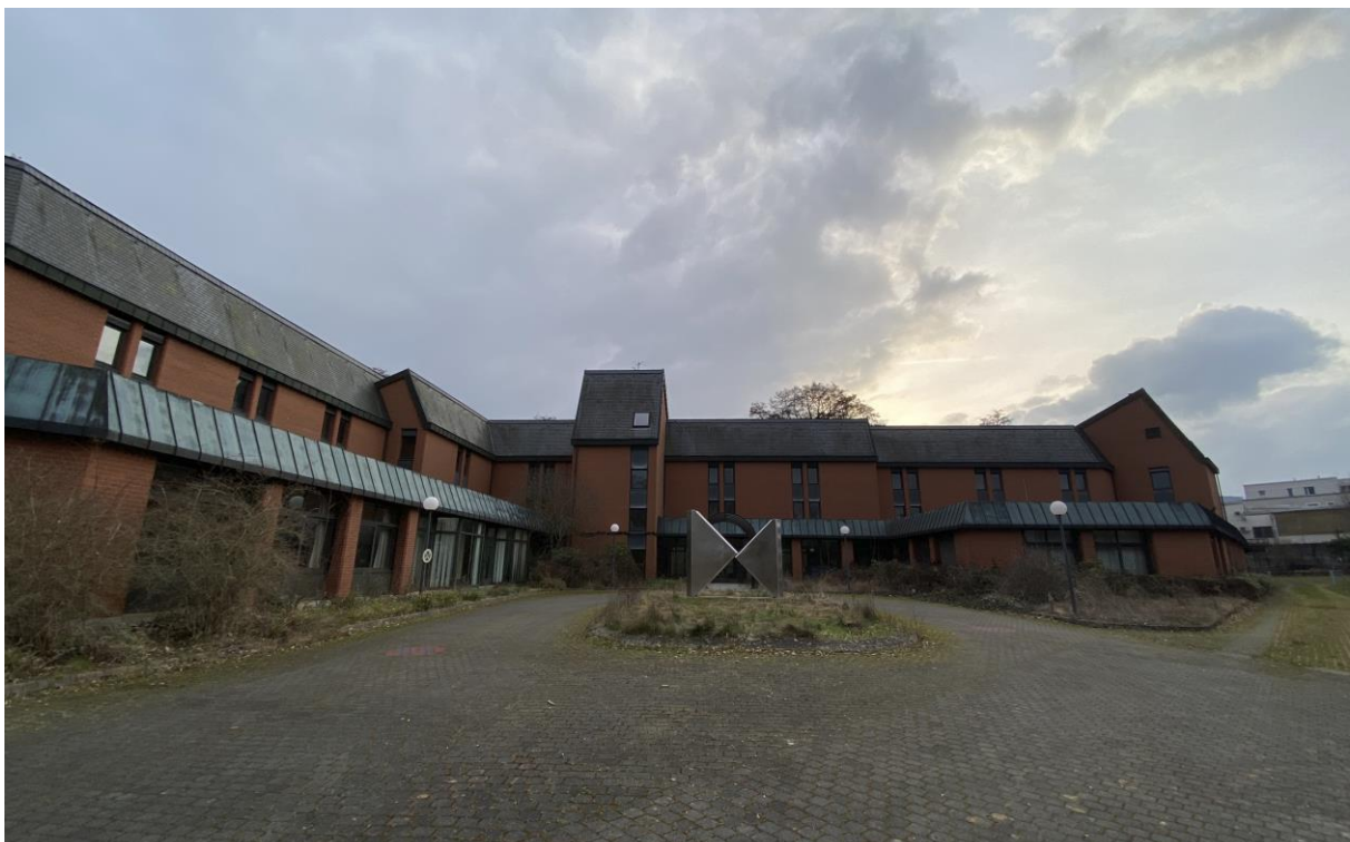
Nord-West Ansicht des Bestandsgebäudes „Hohemarkstraße 104“
