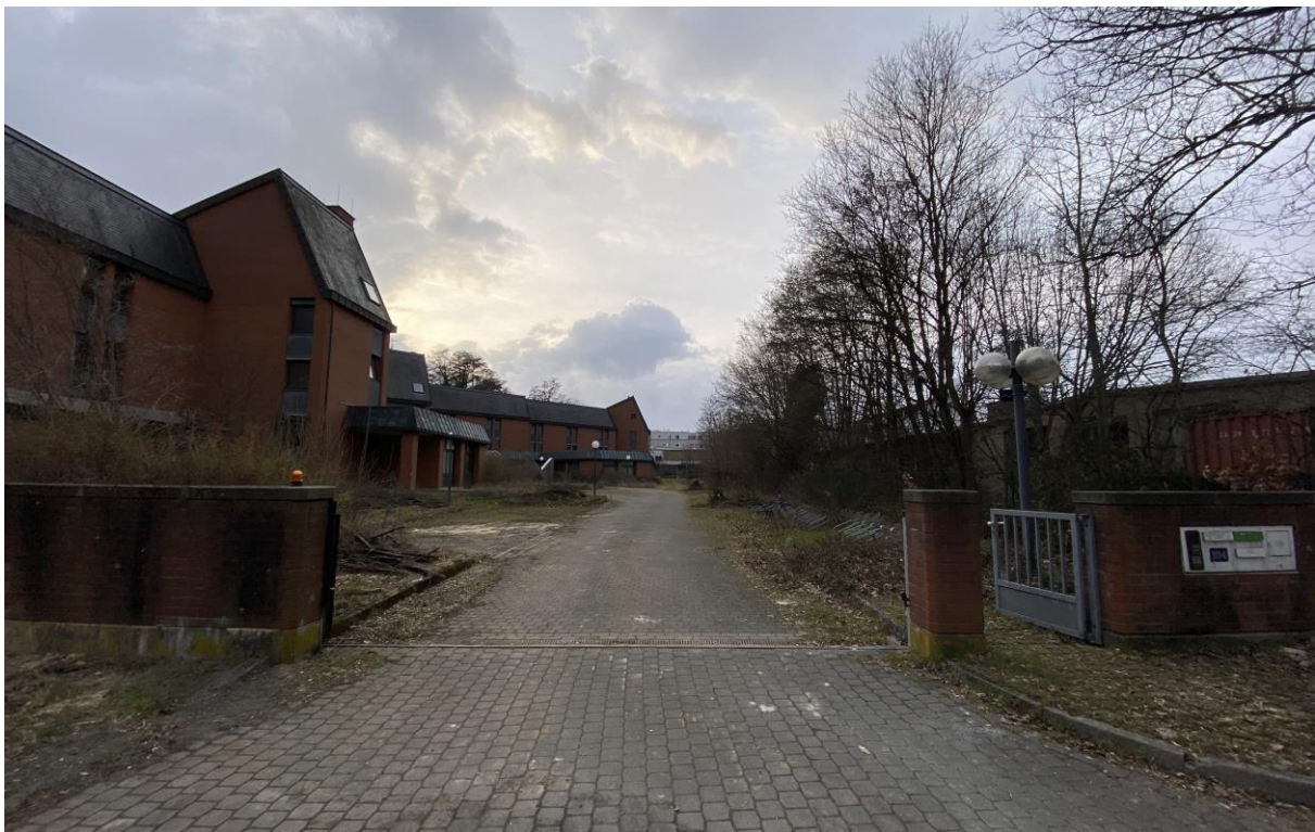
Ansicht Zufahrt auf das Baugrundstück „Hohemarkstraße 104“ (Blick nach Westen in den Fabrikweg)
