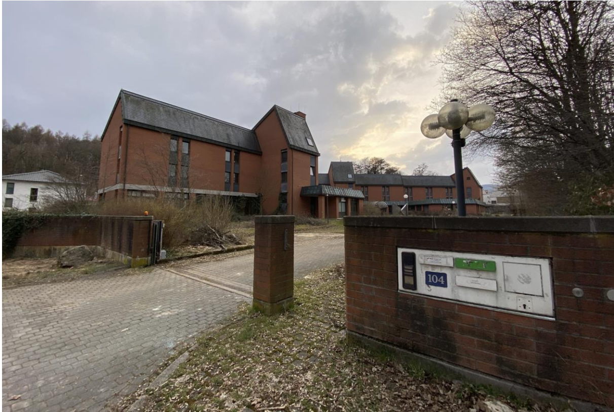
Ansicht Zufahrt auf das Baugrundstück „Hohemarkstraße 104“
