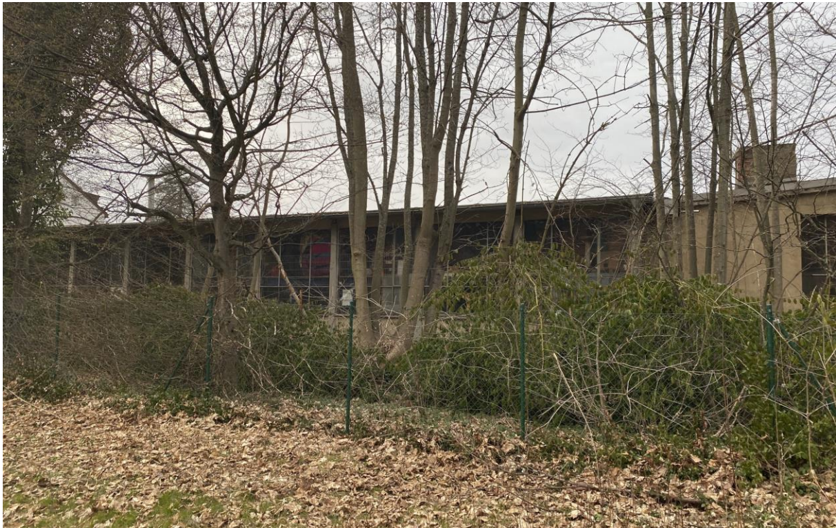
Ansicht der nördlichen Nachbarbebauung (Blick vom Fabrikweg nach Norden)
