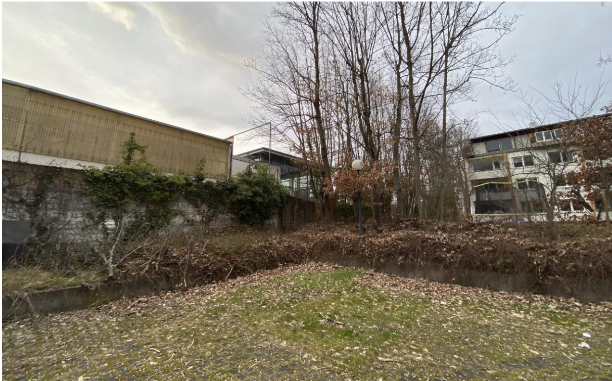
Nachbarbebauung im Westen (links, gewerblich genutzte Fläche) und Norden (rechts, Wohngebäude)
