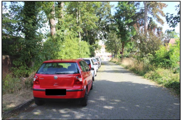
Nahezu versiegelte Fläche, Pflaster, hier: Zufahrtsstraße (KV-Code 10.520)
