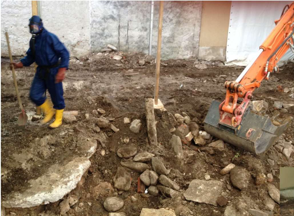
Bauarbeiten, ehem. Bodenplatte Gebäude
