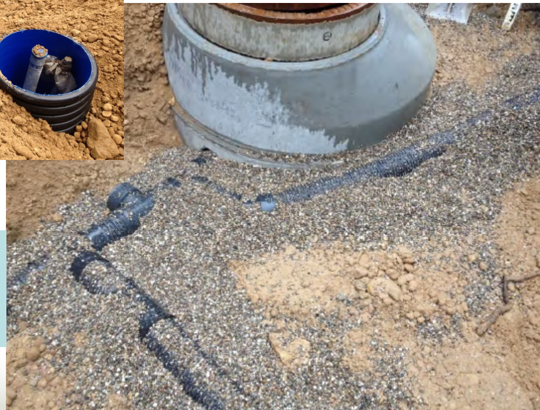
Anschluss Drainage an Schachtbauwerk zur Absaugung
