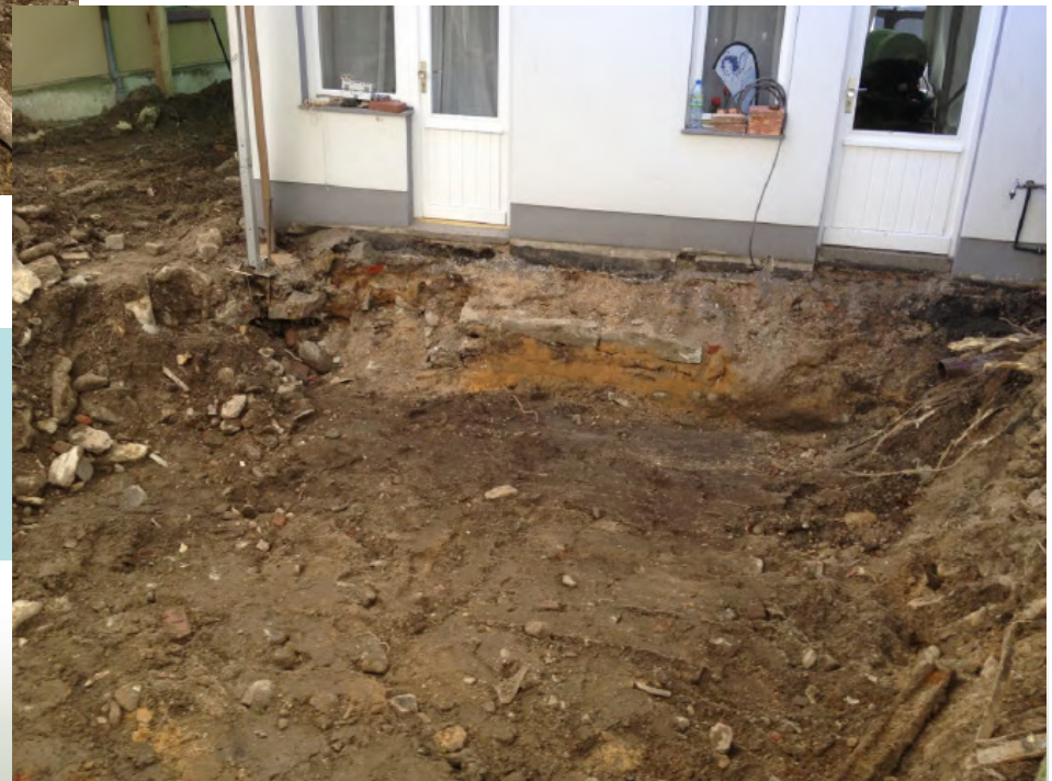
Aushubsohle im Bereich des ehemaligen Unterstandes
