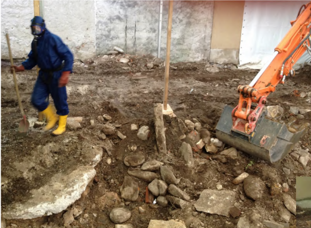
Bauarbeiten, ehem. Bodenplatte Gebäude
