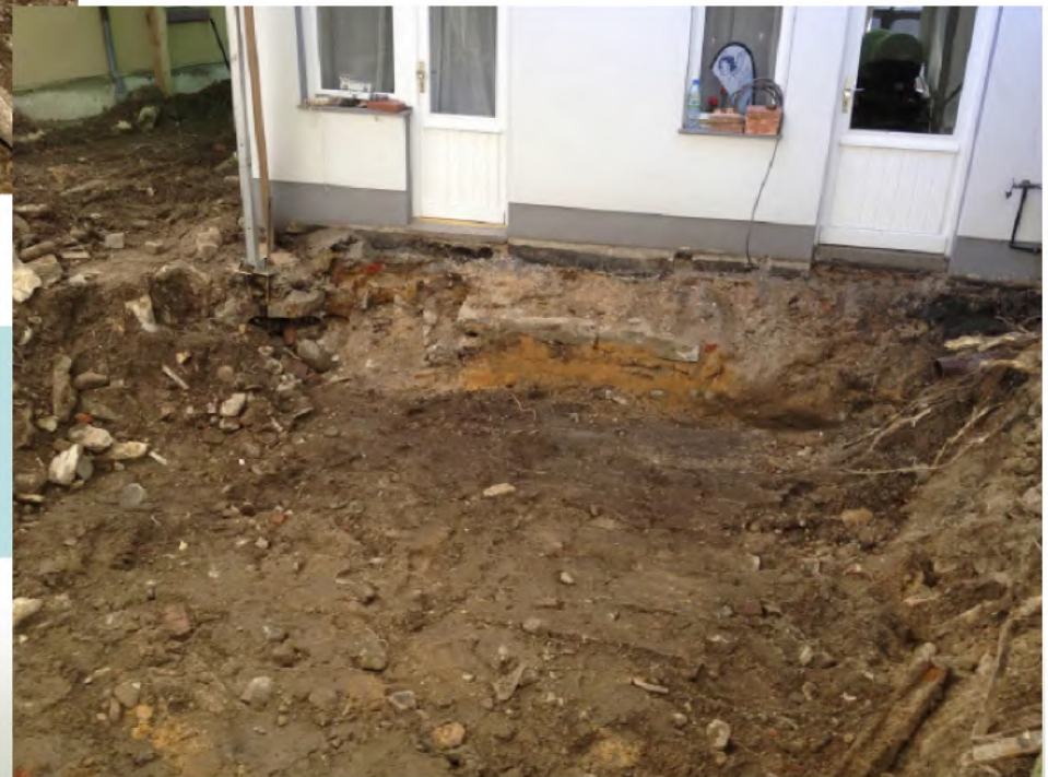
Aushubsohle im Bereich des ehemaligen Unterstandes
