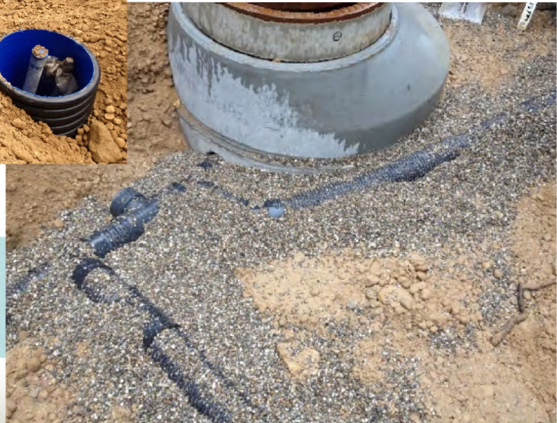
Anschluss Drainage an Schachtbauwerk zur Absaugung
